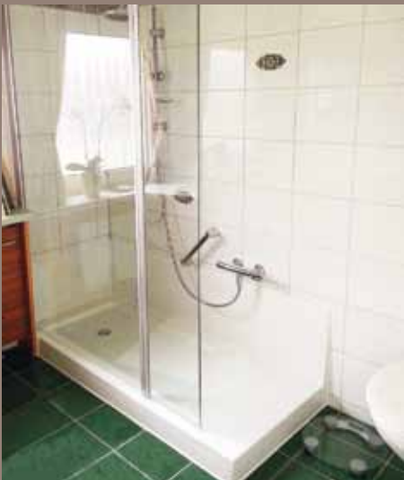
WANNE ZUR DUSCHE Teilsanierung mit System
